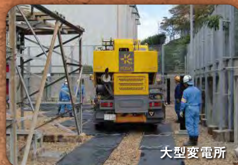
重機仮設駐車場
