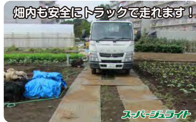
畑内路面養生
