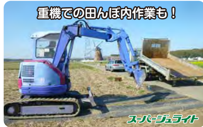
乾田内通路養生
