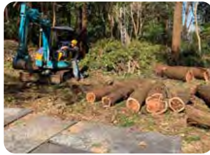
林道 足場養生
