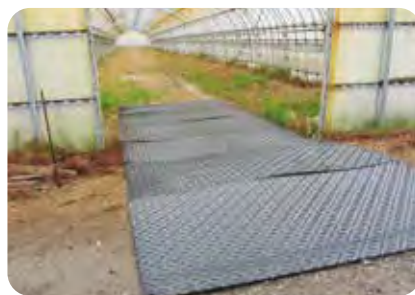
ビニールハウス出入口養生
