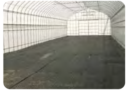
大型ビニールハウス全面養生
