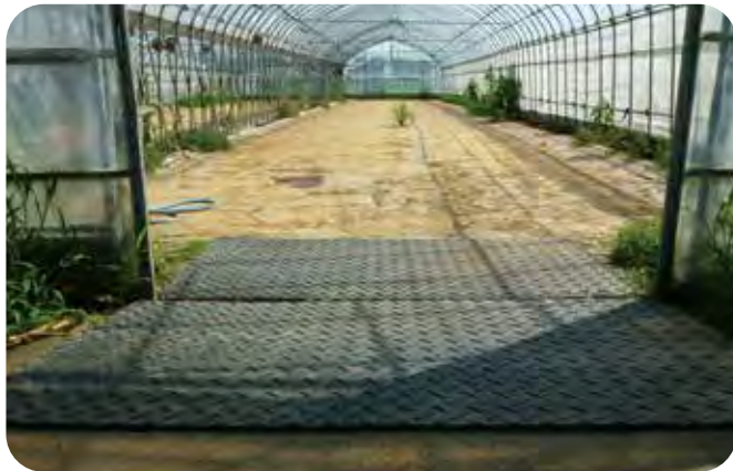
ビニールハウス入口養生
