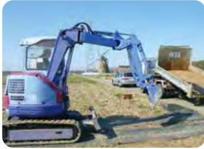
乾田内通路養生
