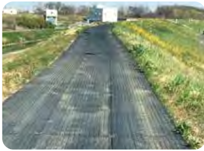
河川専用道路 重機搬入養生
