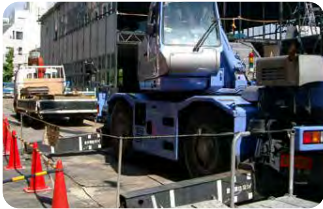
駅舎工事現場
