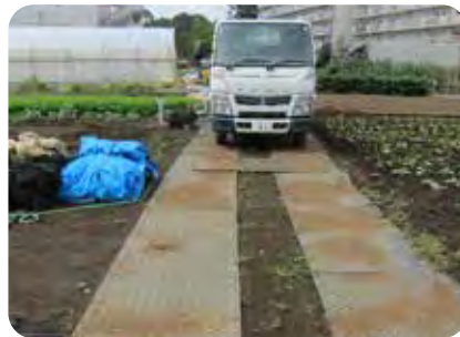
畑内路面養生
