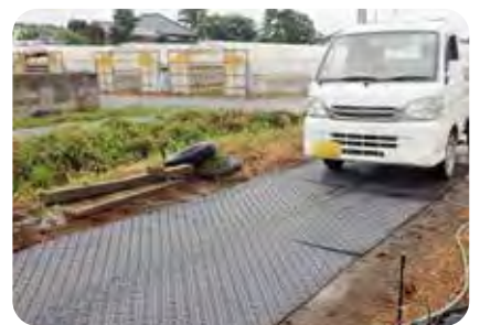
トラックの通路養生
