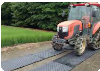
農機走行の路面養生
