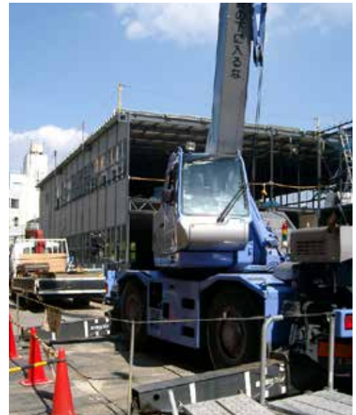
駅舎工事現場
