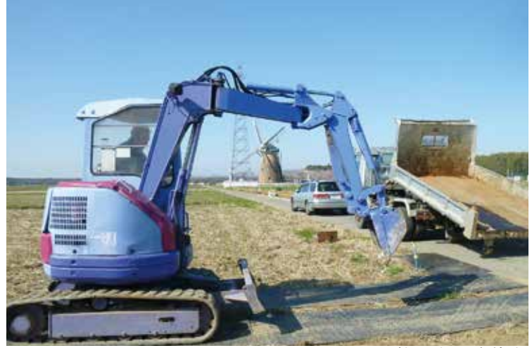
乾田内通路養生
