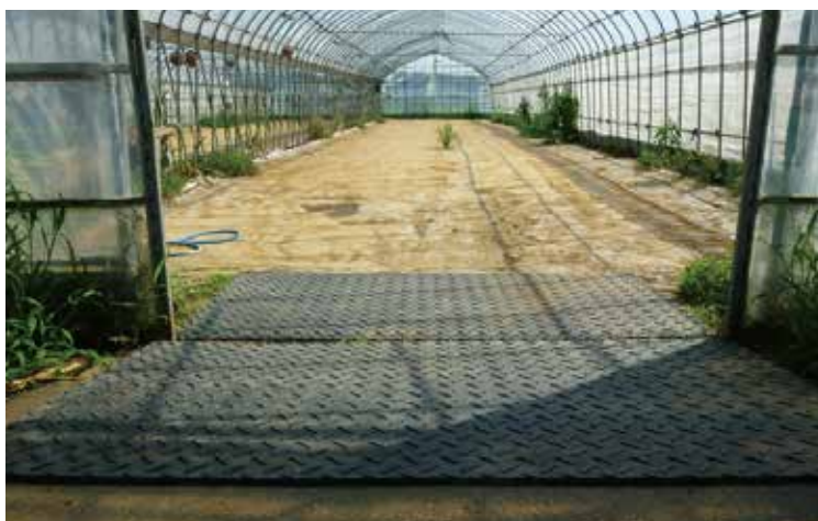
ビニールハウス入口養生
