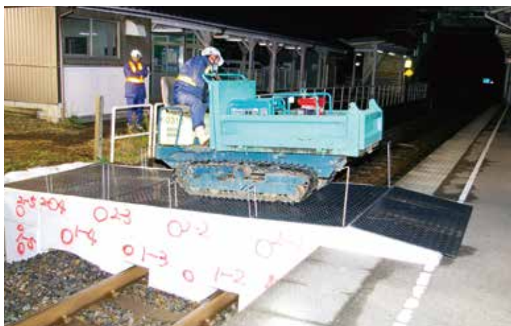
JRホーム横断工法に使用
