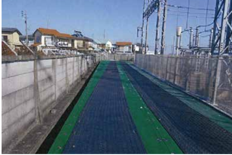
電力会社 変電所敷地養生
