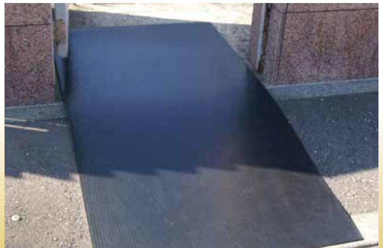
マンション工事現場の通路養生
