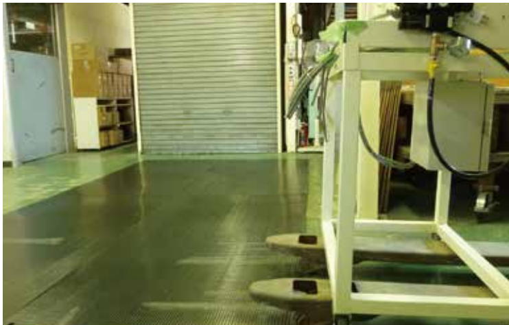
工場内の床の保護
